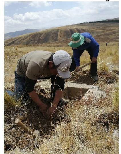
Beim Bau einer Wasserleitung
